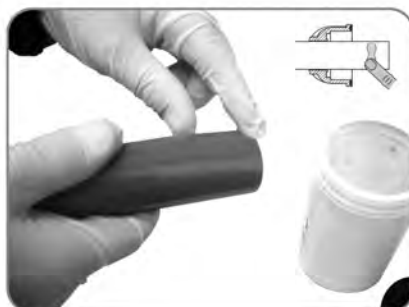
Lubrique la parte exterior del tubo
