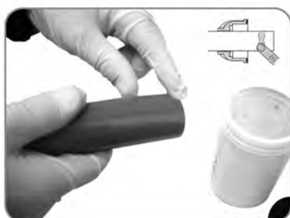
Lubrificare la parte esterna del tubo
