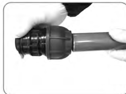
Das Rohr hineinschieben
